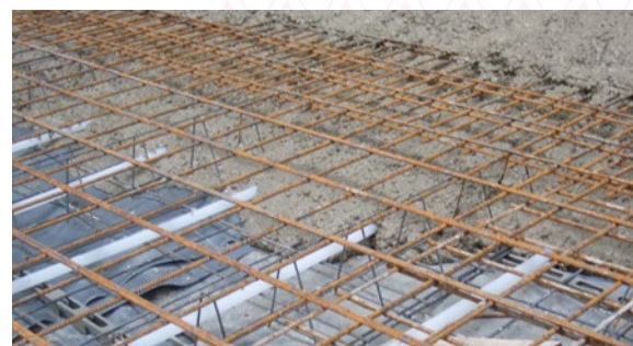
Beispiel: Rohrbefestigung auf der unteren Bewehrung
